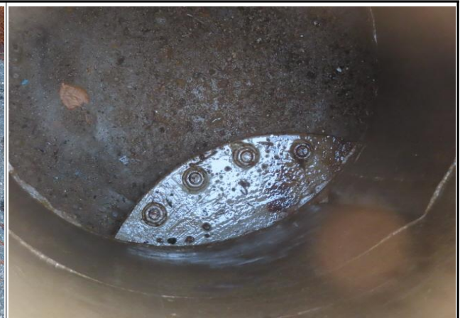
송수2 Sta.140+0.00(점검구실) 구조물 및 마개 상태양호
