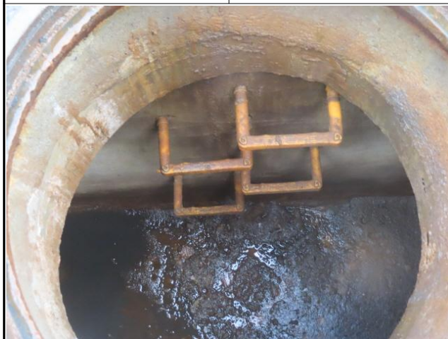
공기밸브실 사다리 설치 상태양호
